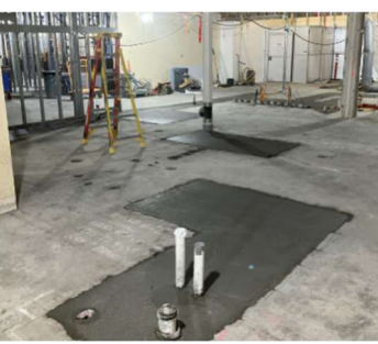
Paradise – Slab Pour Backs
