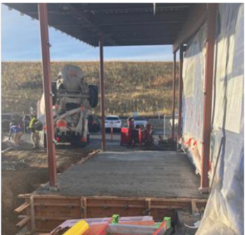
Butch Slab on Grade Pour
